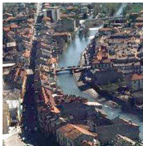
L'edificato storico sulla Dora Riparia
