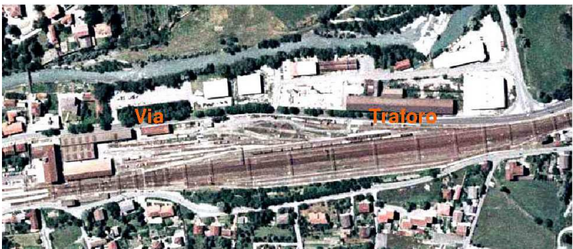
Via Traforo in adiacenza alla linea ferroviaria
